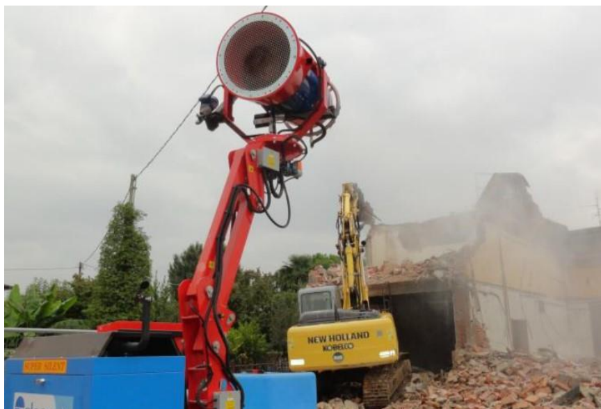
Figura 7. Esempio di utilizzo dei cannoni portatili per l'abbattimento delle polveri durante attività di demolizione
