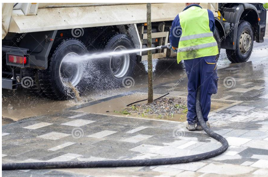
Figura 6. Esempio di attività di lavaggio delle ruote degli automezzi per la riduzione del trasporto di polvere dalle aree di cantiere a quelle esterne limitrofe
