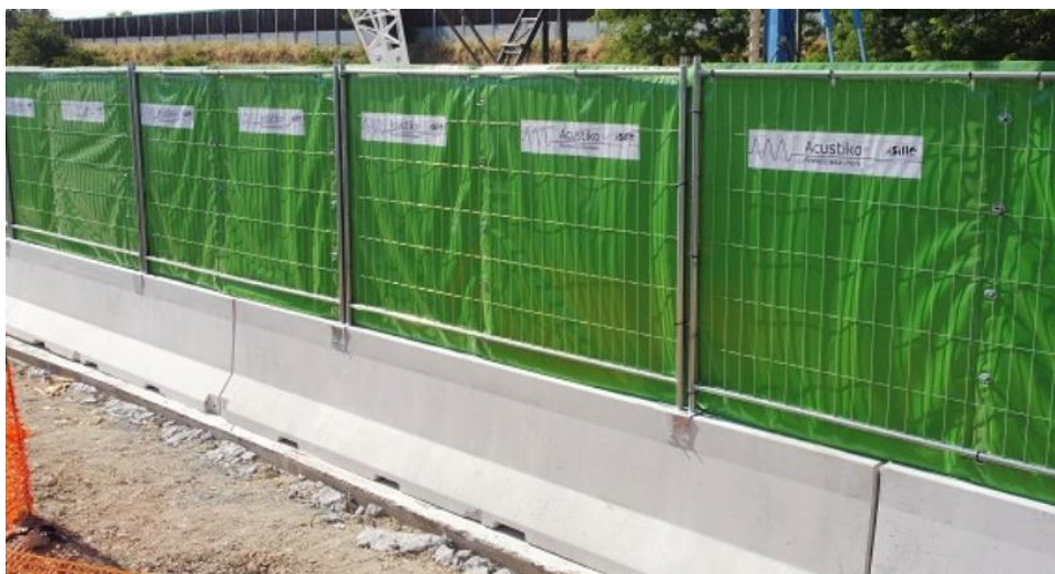
Figura 13. Esempio di barriera visiva e acustica di cantiere
