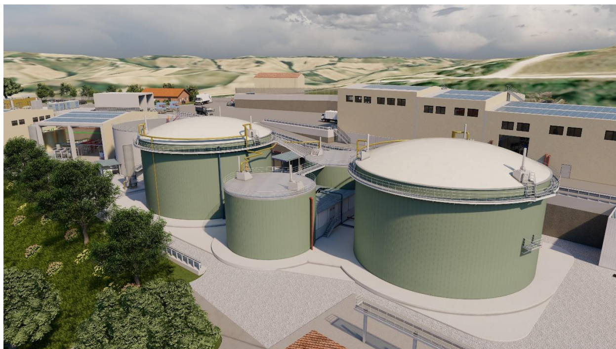
Figura 18 Vista 3D delle vasche di idrolisi e dei digestori nella nuova configurazione proposta
