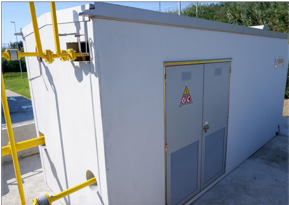
Figura 13 – Esempio di cabina REMI alloggiata in cabinato in Cemento Armato Vibrato
