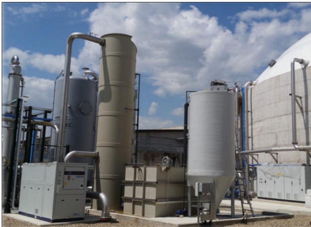
Figura 6 – Torre scrubber per abbattimento dell'acido solfidrico
