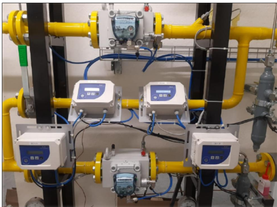
Figura 14 – Particolare della componente di misura volumetrica all'interno della cabina REMI
