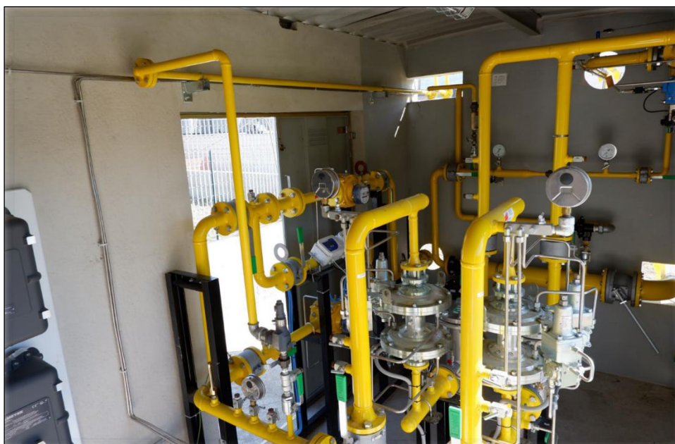
Figura 15 – Particolare del piping e del sistema di supporto all'interno della cabina REMI
