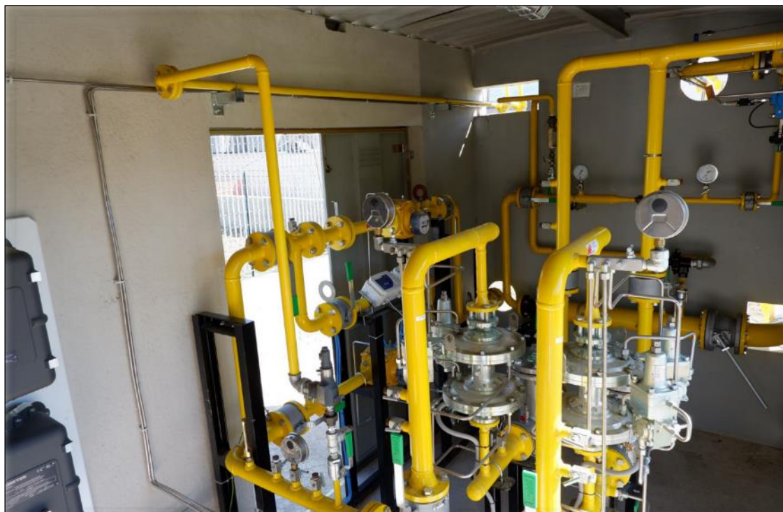
Figura 20 – Particolare del piping e del sistema di supporto all'interno della cabina REMI
