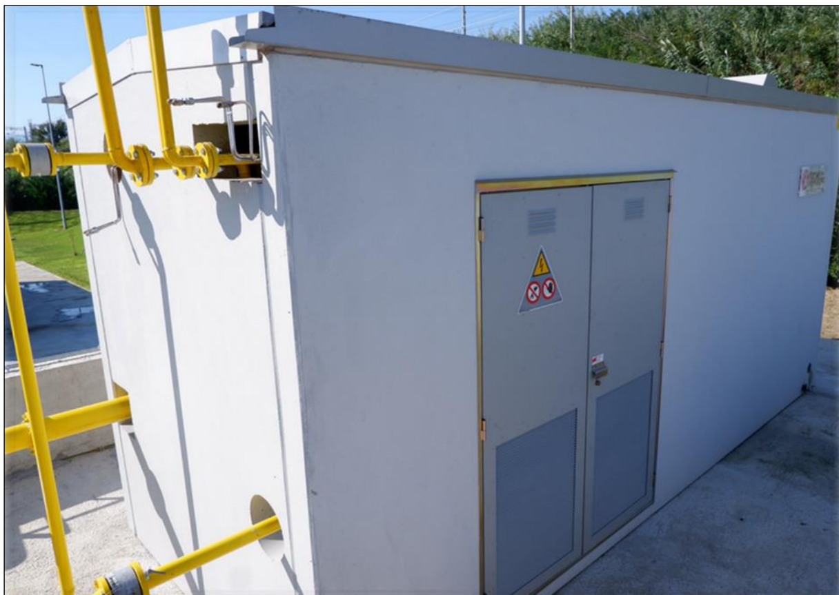
Figura 18 – Esempio di cabina REMI alloggiata in cabinato in Cemento Armato Vibrato
