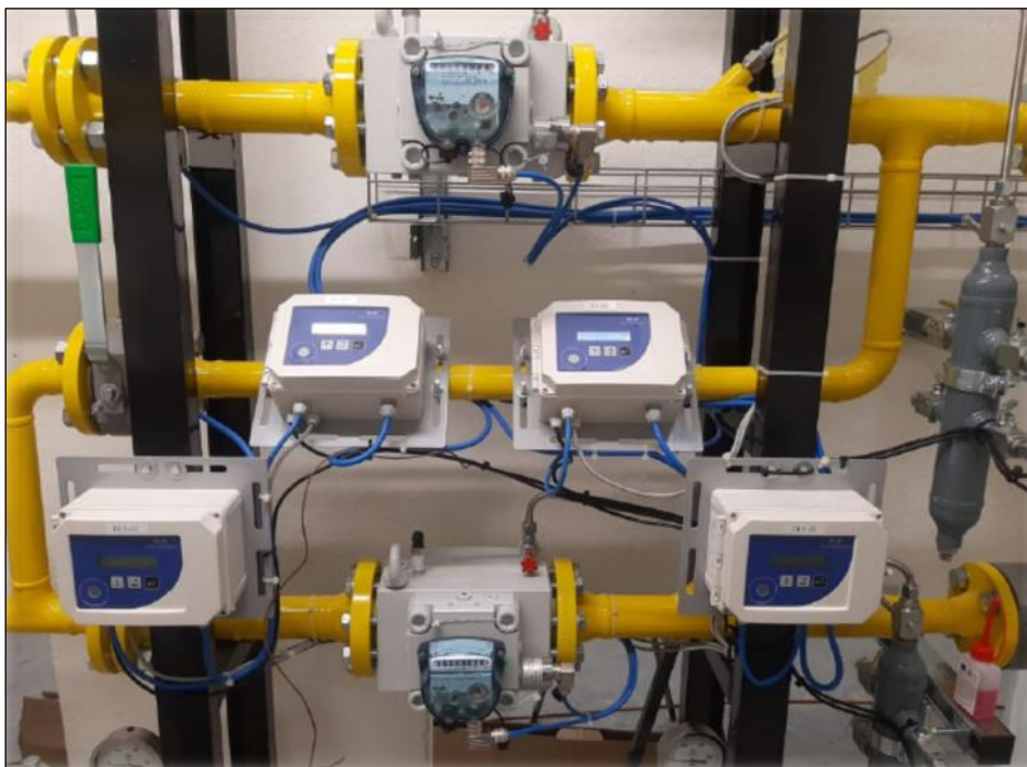
Figura 19 – Particolare della componente di misura volumetrica all'interno della cabina REMI
