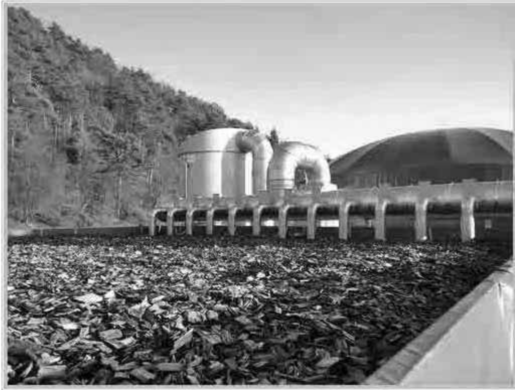
Fig. 2: Biofiltro con vasca con pareti in pannelli sandwich.
