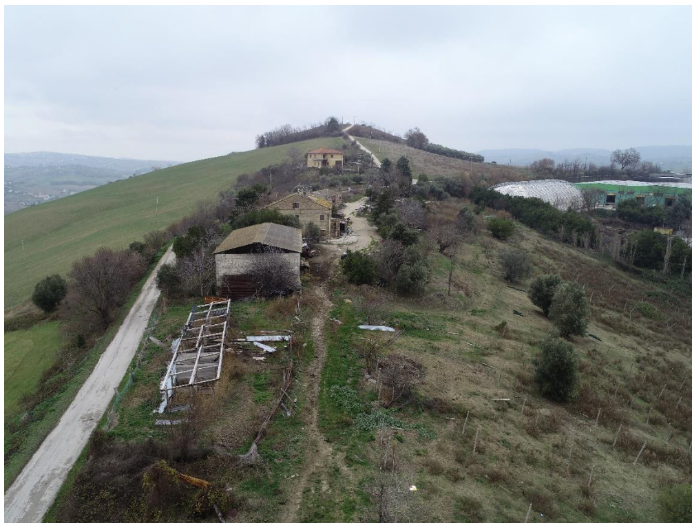
Figura 2. Foto aerea (drone) dell'area di cantiere
