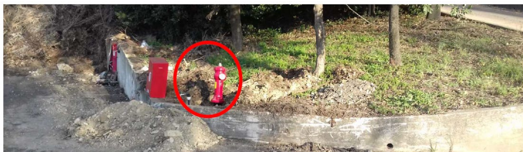
Figura 11 foto dell'idrante soprasuolo e rubinetto
