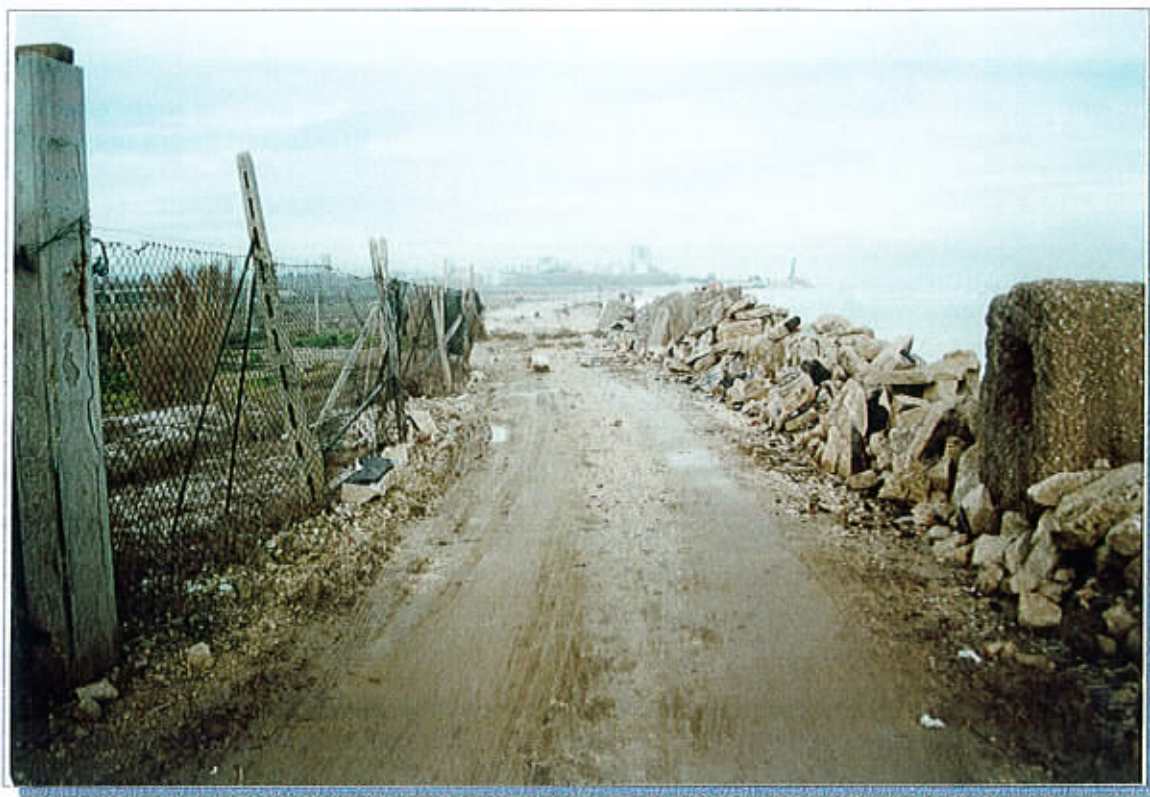
Settore San Tommaso - Tre Archi
