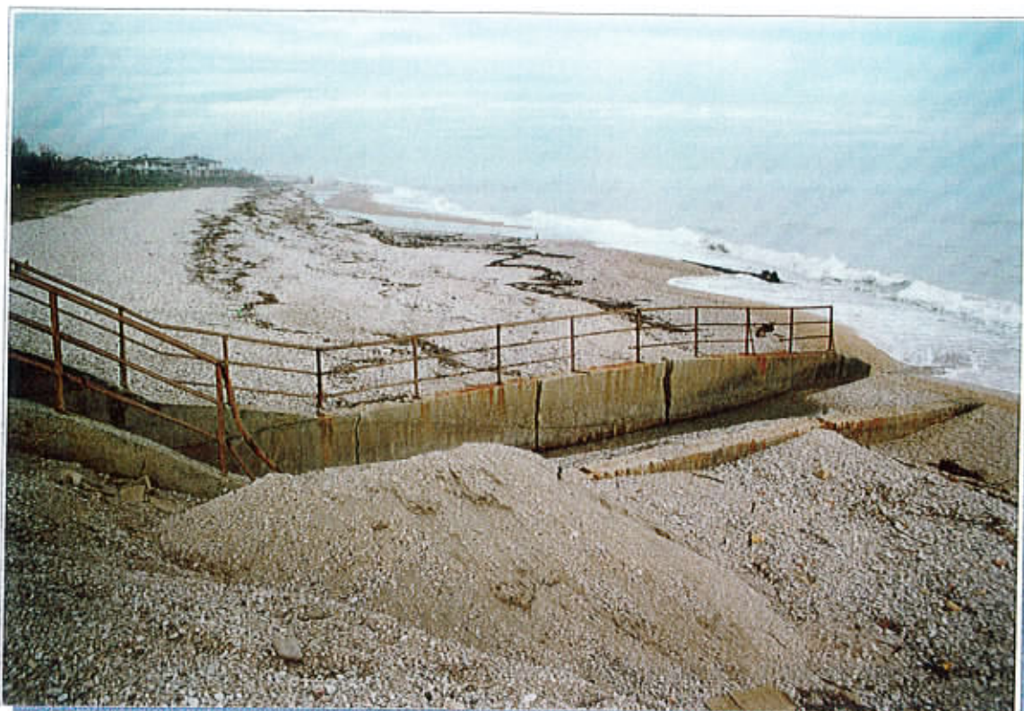
Settore San Tommaso - Tre Archi
